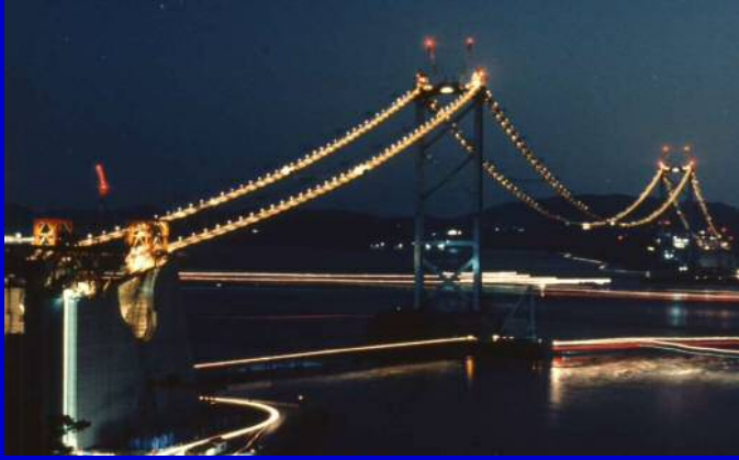
大鳴門橋での夜間におけるケーブル架設作業の様子
